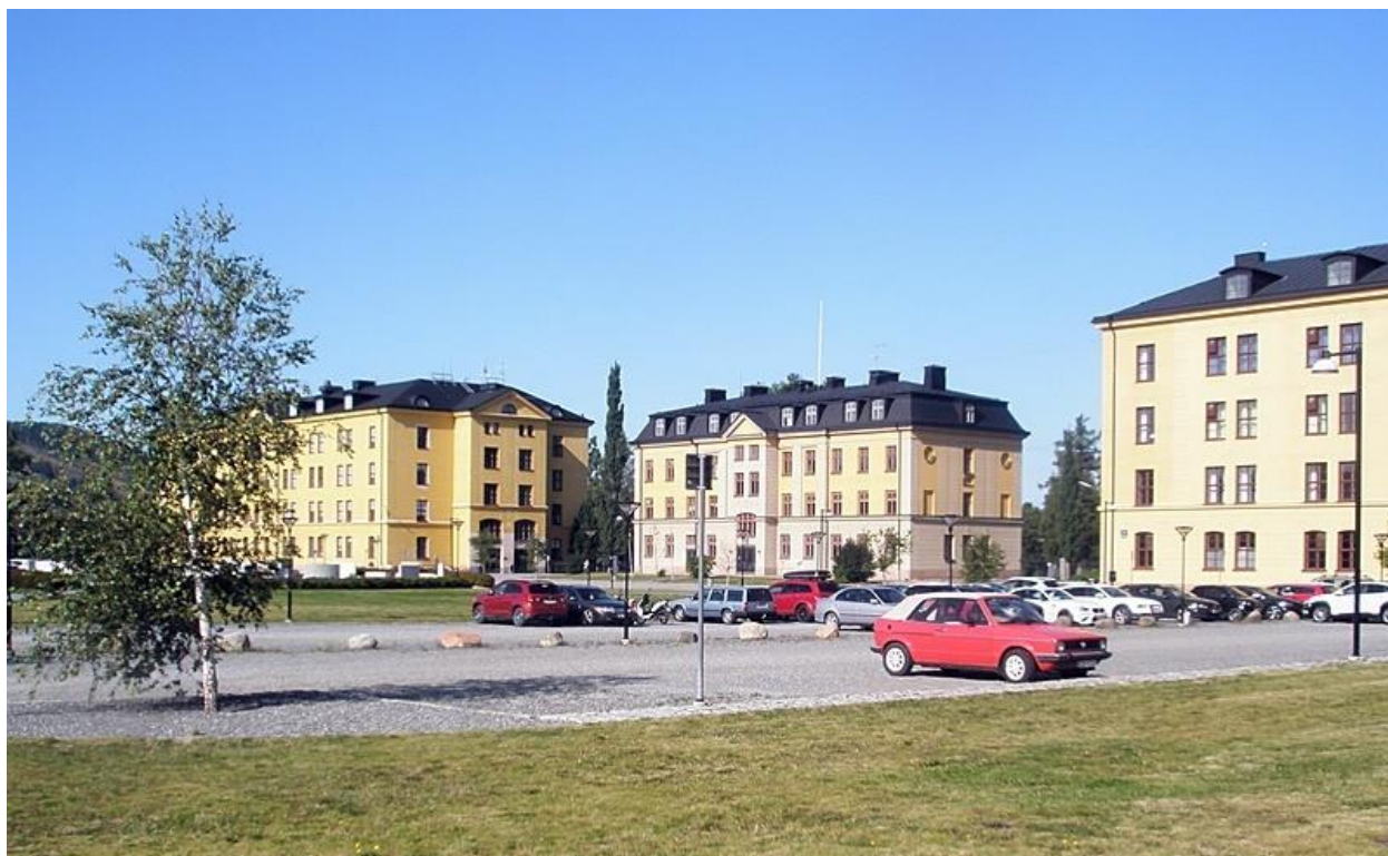
Del av I 21 tidigare kaserngård sedd från C-kasern 2019-08-22 kl 1110. I mitten kanslihuset, t v B-kasern och t h A-kasern. Foto S-O Braf.
