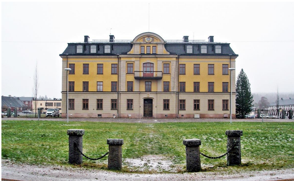
Det tidigare kanslihuset på Västernorrlands Regemente fotograferat den 4 december 2018. Foto S-O Braf.
