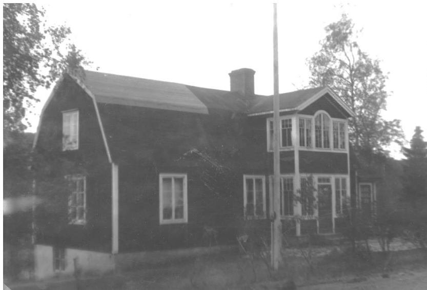
Fastighet Överskog 1:12 och 1:13. Tillbyggnaden ser man på taket, den ljusa takappen.
