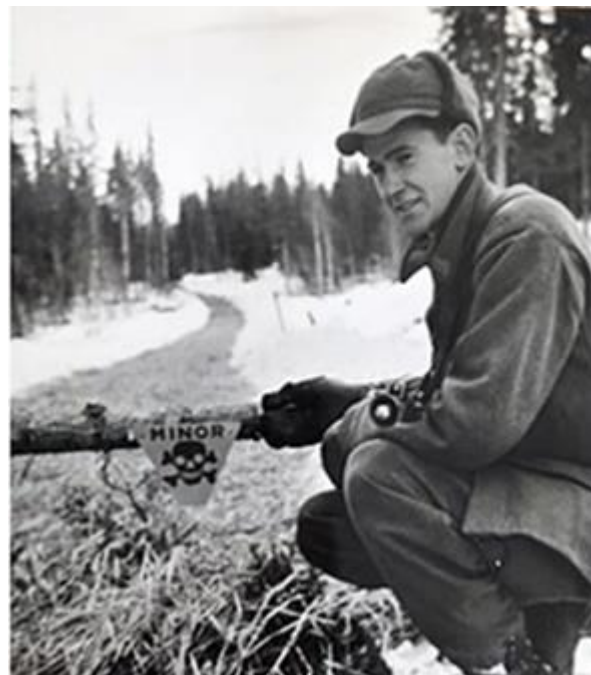
Håkan Westberg vid en stridsvagnsminering. De i vägbanan och i den omgivande terräng nedgrävda minorna är försåtminerade. Minorna på vägen är maskerade med granris. Nästa snöfall kommer att förbättra deras maskering ytterligare. Foto författaren.
