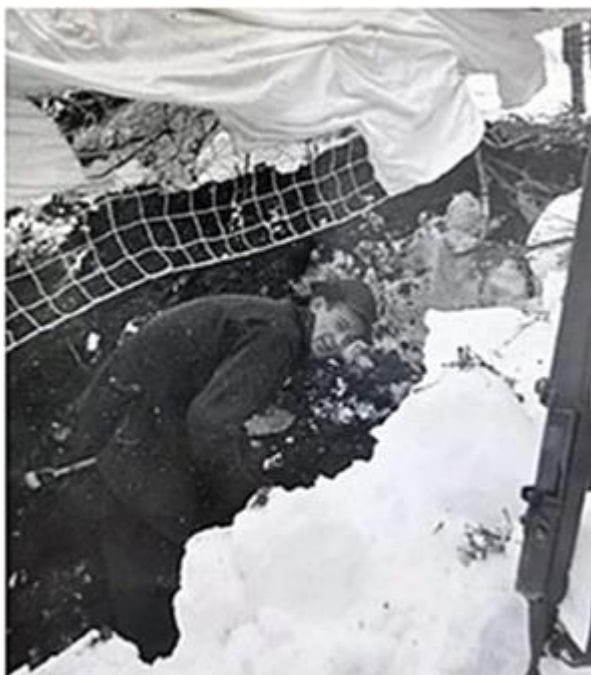
Under arbetsmaskeringen grävs det på vad som skall bli ett ståvärn med splitterskydd. Notera automatgeväret till höger som står på en armslängds avstånd från den grävande. Foto författaren.
