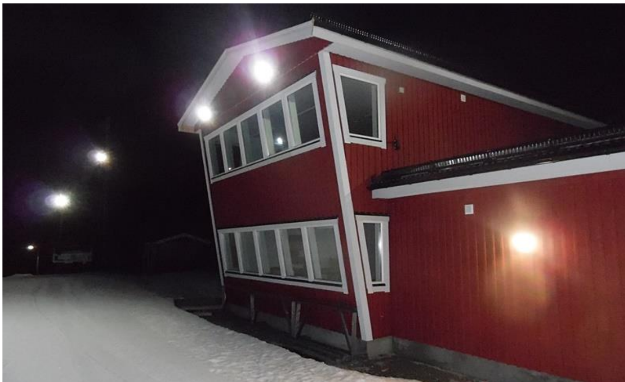
I den nya hallen disponerar tidtagarna utrymmet bakom fönstren i bottenvåningen och speakern har sin plats på övervåningen. Foto från I 21 IF.
